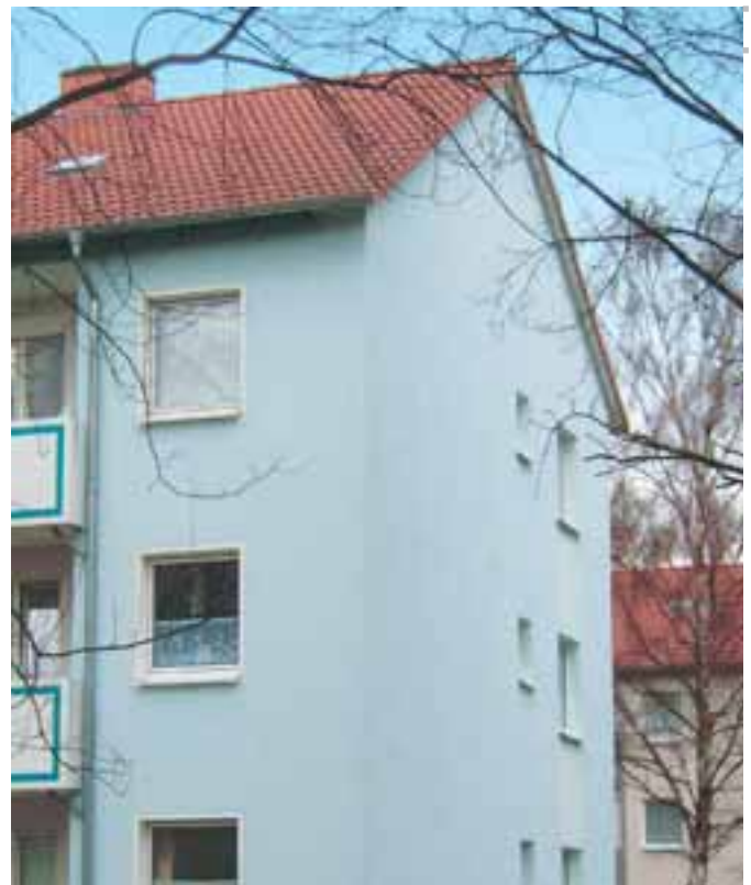
Soojustussüsteemiga renoveeritud fassaad
