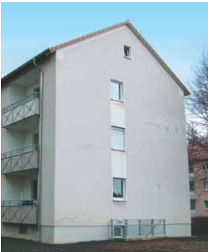
Ilmastikumõjude tagajärjel riknenud fassaad
